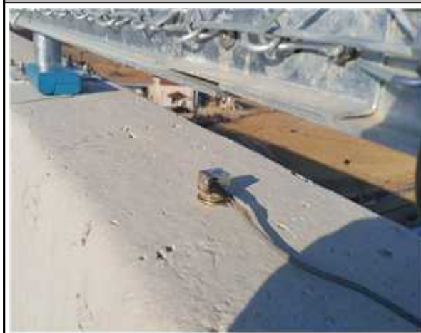
가속도계 설치 현황
