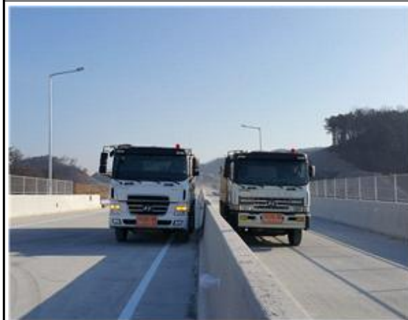
정적 재하시험 전경
